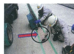
橋面断面修復部
