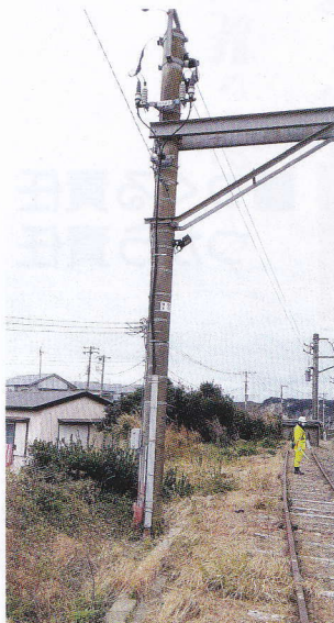
●コンクリート柱施工前
