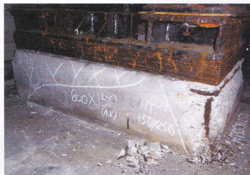
●ガス管架台施工前
